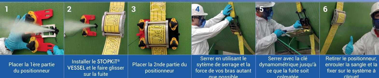
\* Pour installer le STOPKiT® VESSEL sur une cuve sous pression verticale, une étape supplémentaire est nécessaire (entre les étapes 1 et 2) pour fixer la sangle avec le système aimanté
